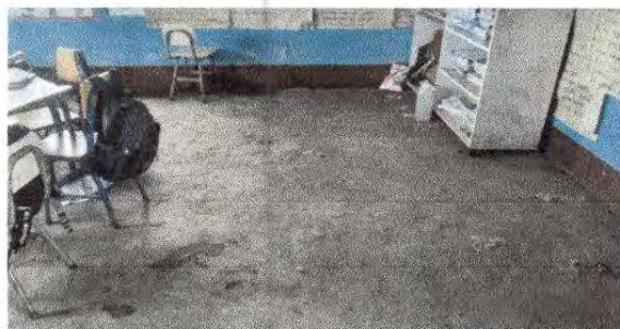
Foto 6: Sustrucion de piso de granito
