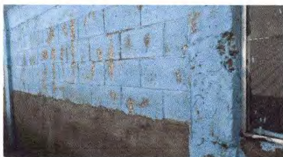
Foto 3: Pintura en muros exteriores e interiores
