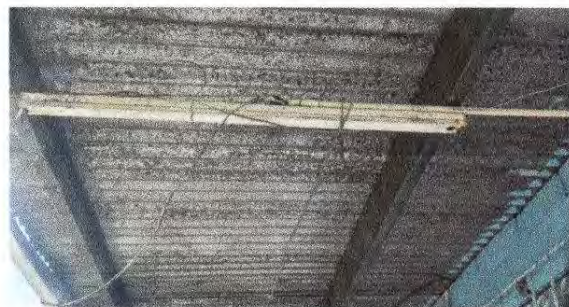
Foto 3: Sustrucción de plafoneras
