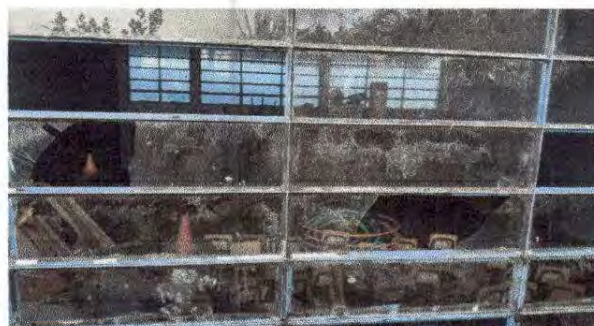
Foto 4: Sustrucion de vidrios
