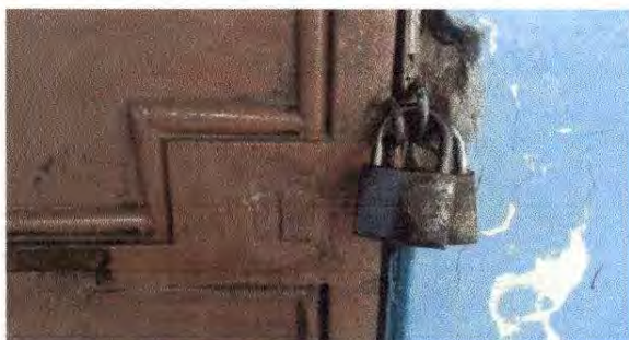
Foto 3: Sustrucion de chapa
