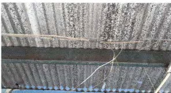
Foto 5: Reparación de cableado eléctrico
