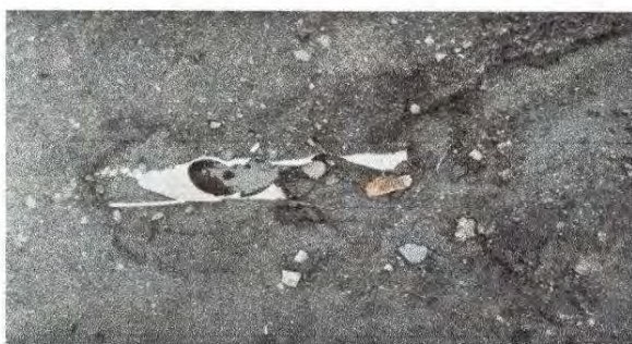
Foto 5: Sustrución de tubería PVC línea principal aguas negras
