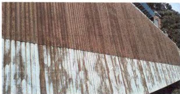
Foto1: Sustrucion de lámina, por lámina troquelada aluzing calibre 26
