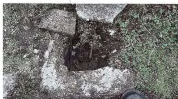
Foto 6: Sustrución de caja de registro
