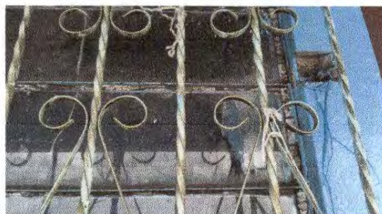
Foto 5: Sustrucion de balcones de metal
